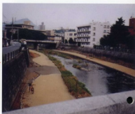
その後破損等異常なし
